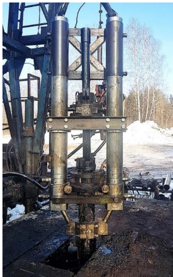
Рис. 3. Работа домкрата на скважине
